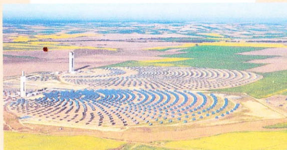
最新型太陽集光システム (スペイン・米でMW級発電用として実用化)
